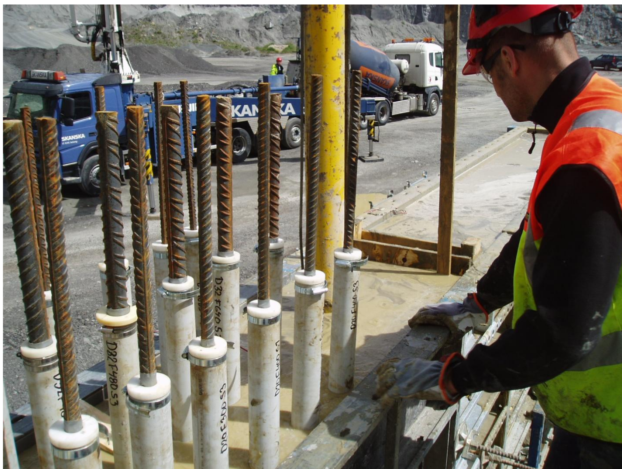
Figur 9: Gjutning av vägg S2.
