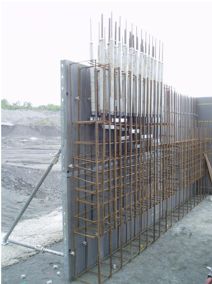
Figur 4: Provvägg S1 och S2 under uppförande. Provvägg S2 med armeringsjärn för dragprov närmast kameran.
