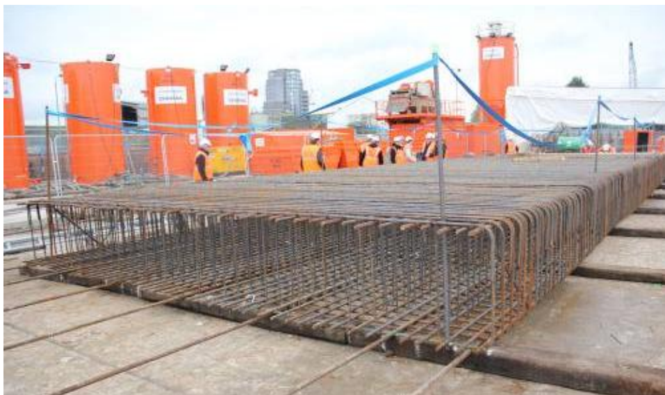
Figur 46. Exempel på platstillverkad armeringskorg.
