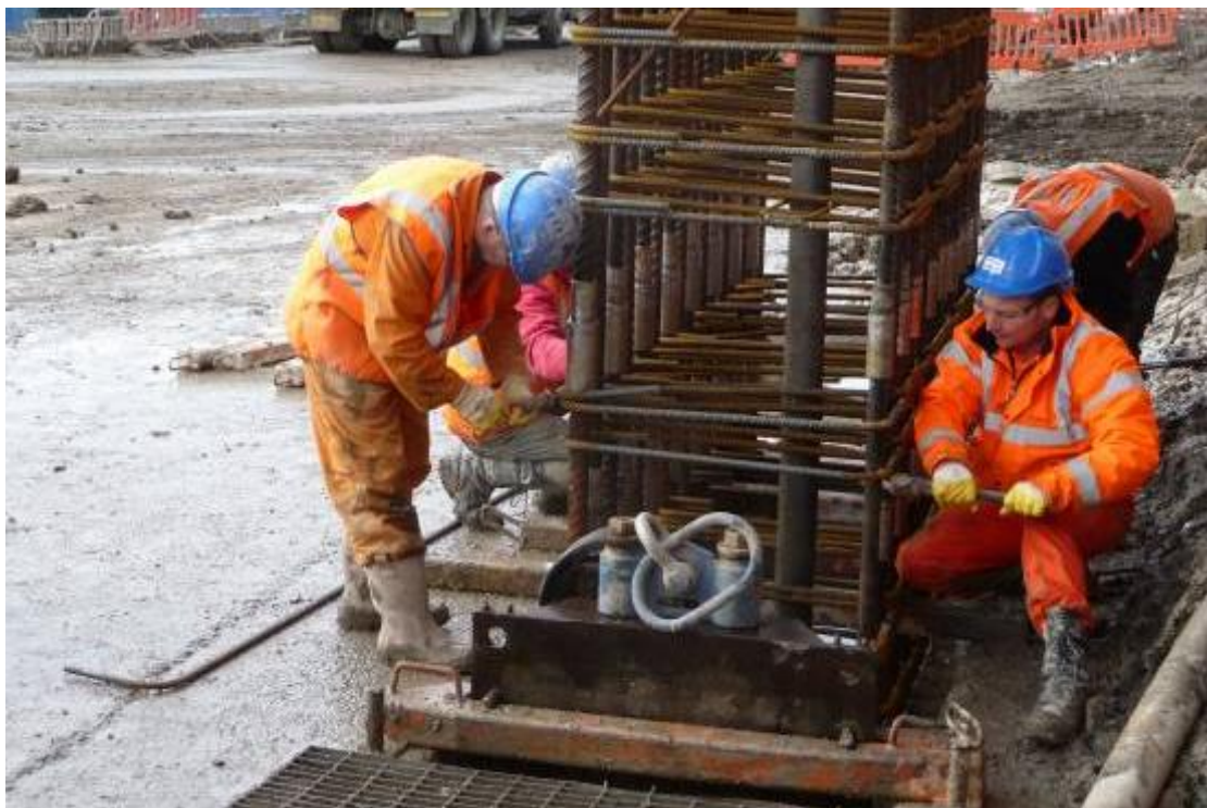
Figur 54. Skarvning av två armeringskorgar.
