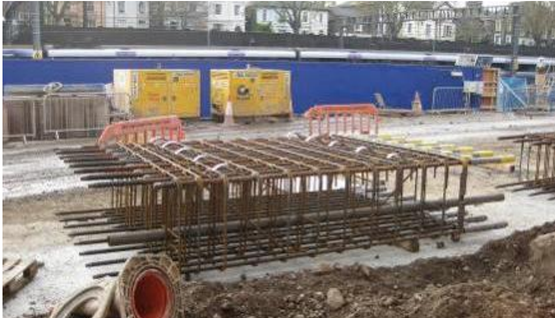
Figur 53. Exempel på prefabricerad sektion av armeringskorg.
