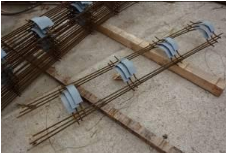
Figur 48. Distanser ”Slädar” för tillräckligt täcksikt
