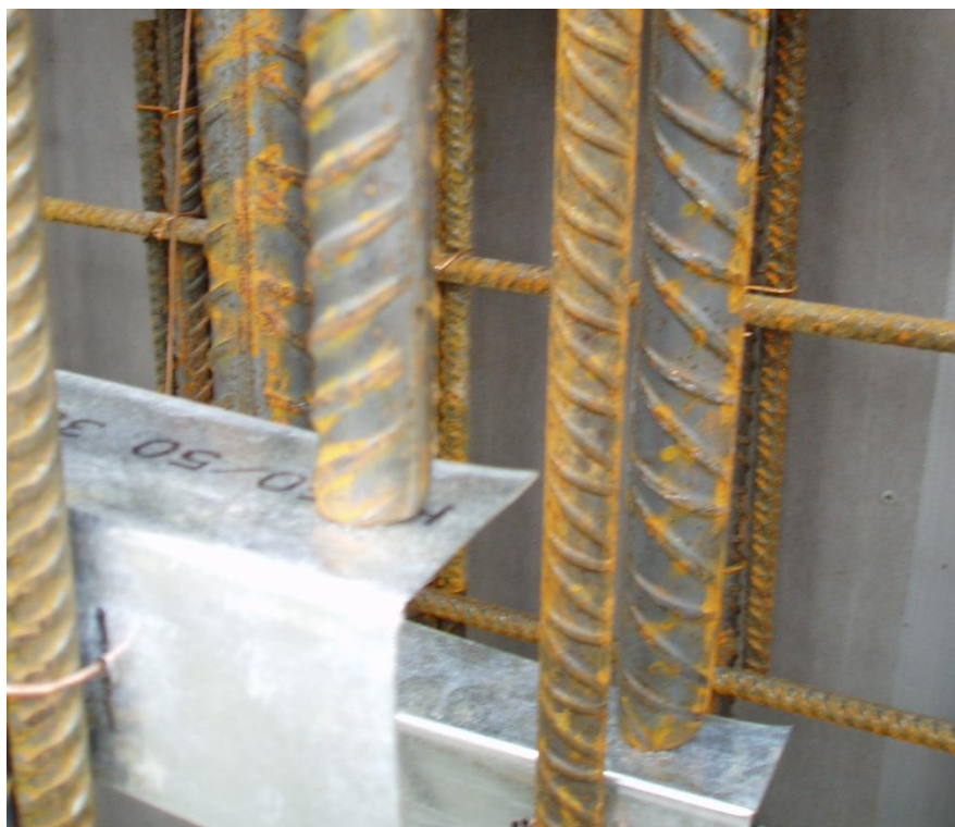
Figur 35: Dragjärn monterat på tunnplåtsprofil.
