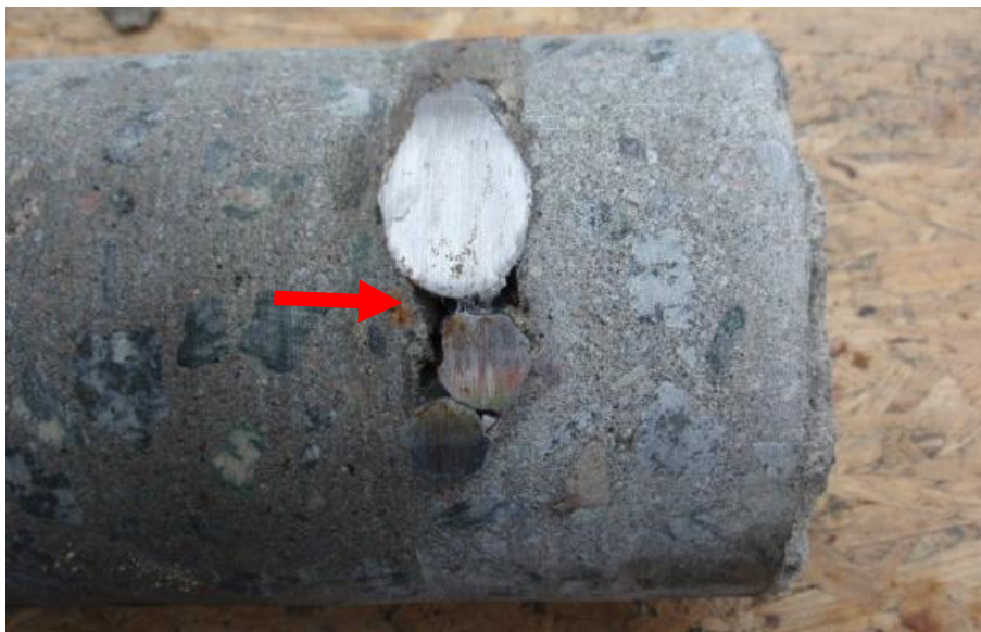
Figur 21: Hålighet efter bentonitansamling kring armering vid omlottskarv.
