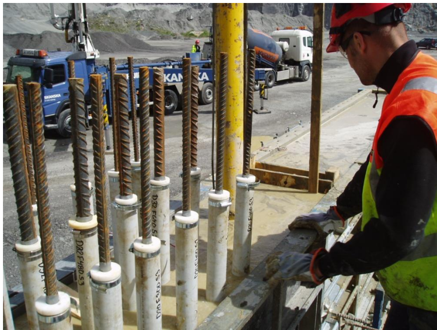
Figur 36: Plaströr kring dragjärn som skydd.
