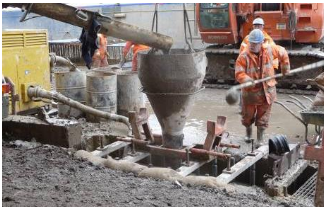
Figur 56. Gjutning av slitsmurspanel mha tremie-pipe
