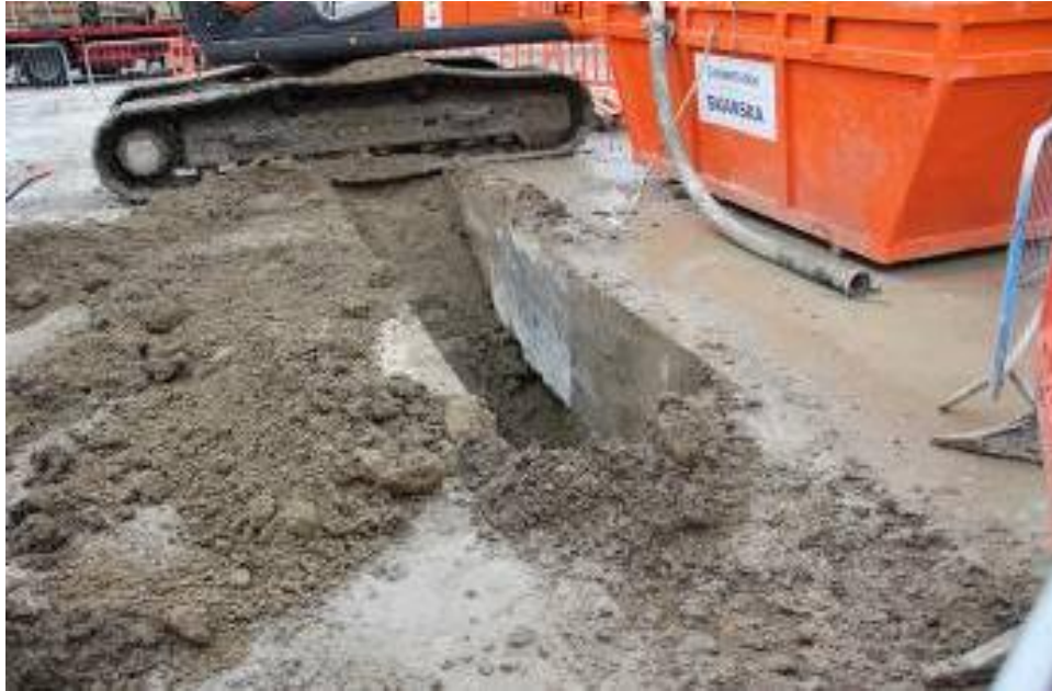
Figur 49. Platsgjutna styrväggarna (guidewalls).
