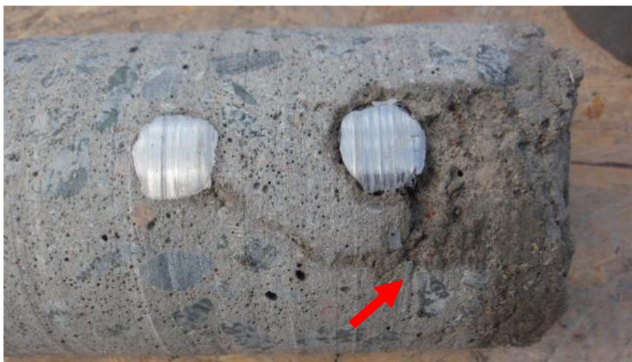
Figur 19: Exempel på kraftigare ansamling av bentonit kring armeringsjärn.
