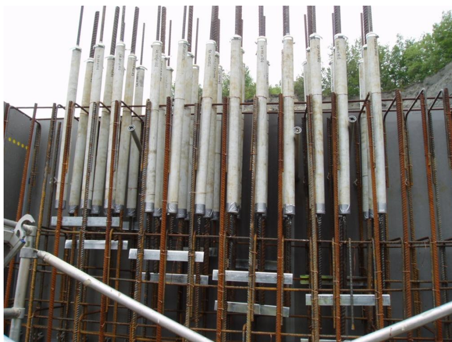
Figur 33: Dragjärn monterade i form.
