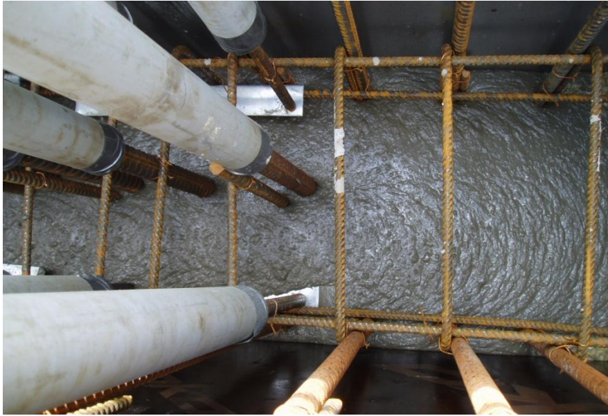
Figur 13: Gjutning av provvägg R1 i torrhet.
