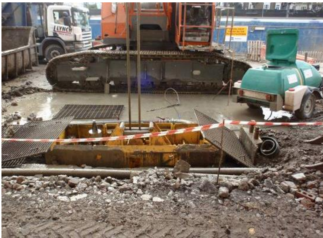
Figur 51. Schaktning av en slitsmurspanel.
