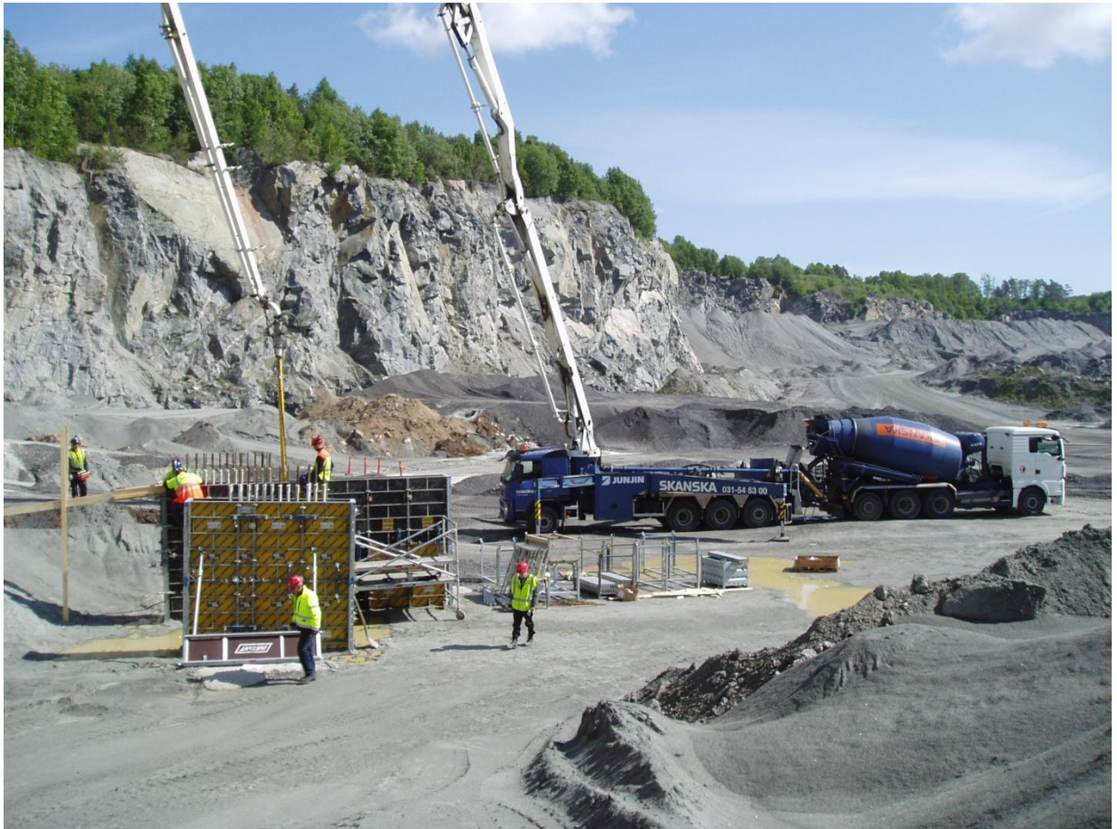
Figur 5: Gjutning av provväggar med betongpump och betongbil.
