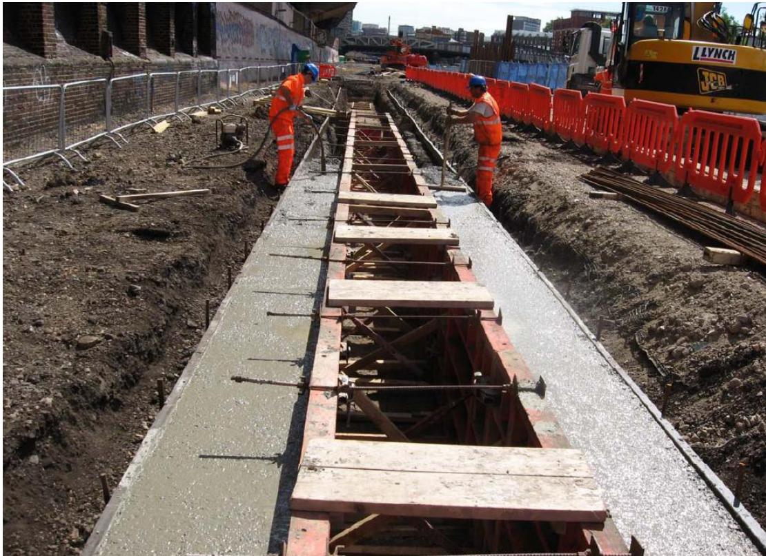
Figur 50. Tillverkning av guide walls
