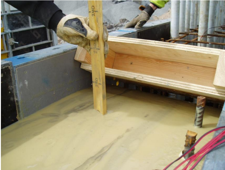
Figur 7: Lodning av gjutnivån under gjutning.
